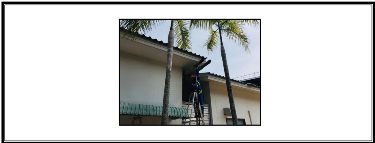
รูปที่ 3.1-1 จุดตรวจวัดคุณภาพอากาศจากปล่องปล่อยทิ้งอากาศเสีย บริเวณปล่อง Generator ในวันที่ 1 มิถุนายน พ.ศ. 2566
